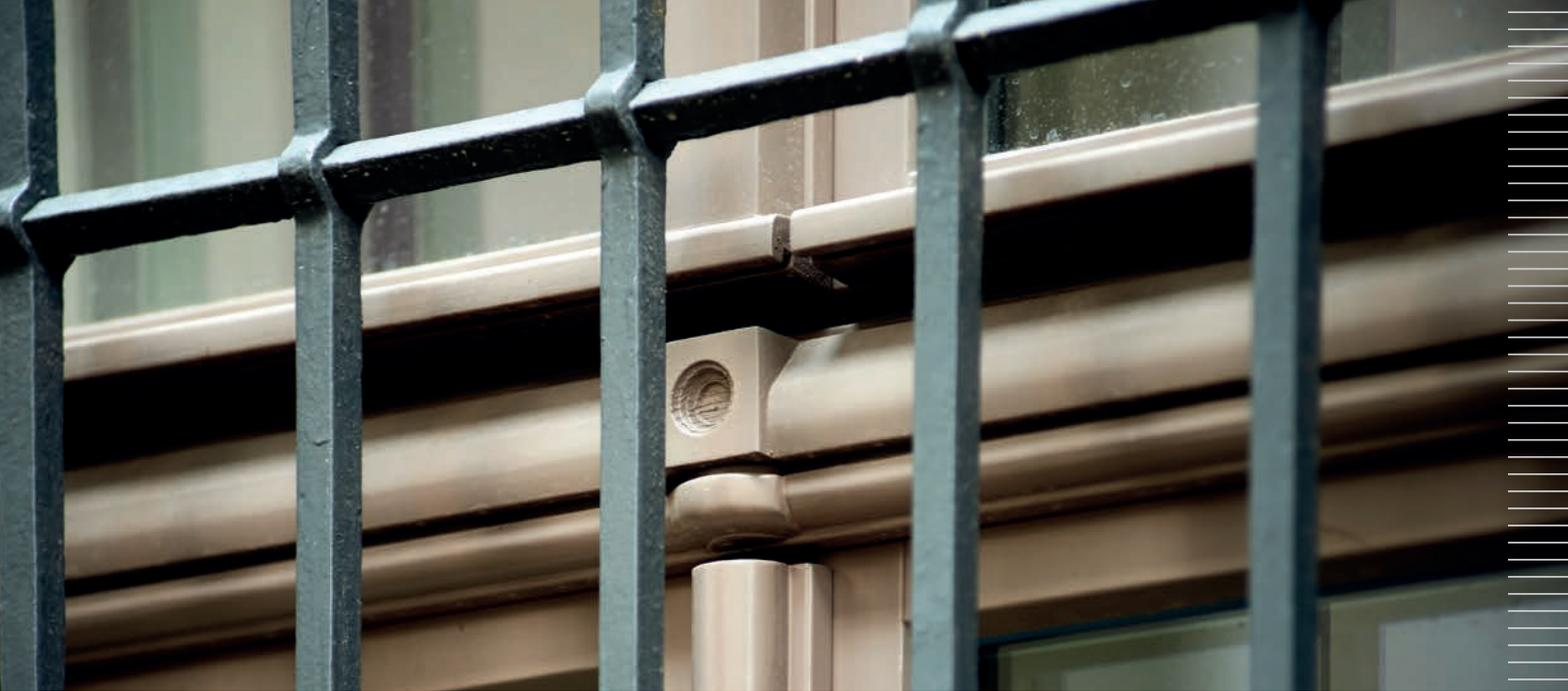
**Regenschutzschienen** sind eine Komponente im Fenster, um tropfendes Regenwasser aufzufangen und sauber abzuleiten.
